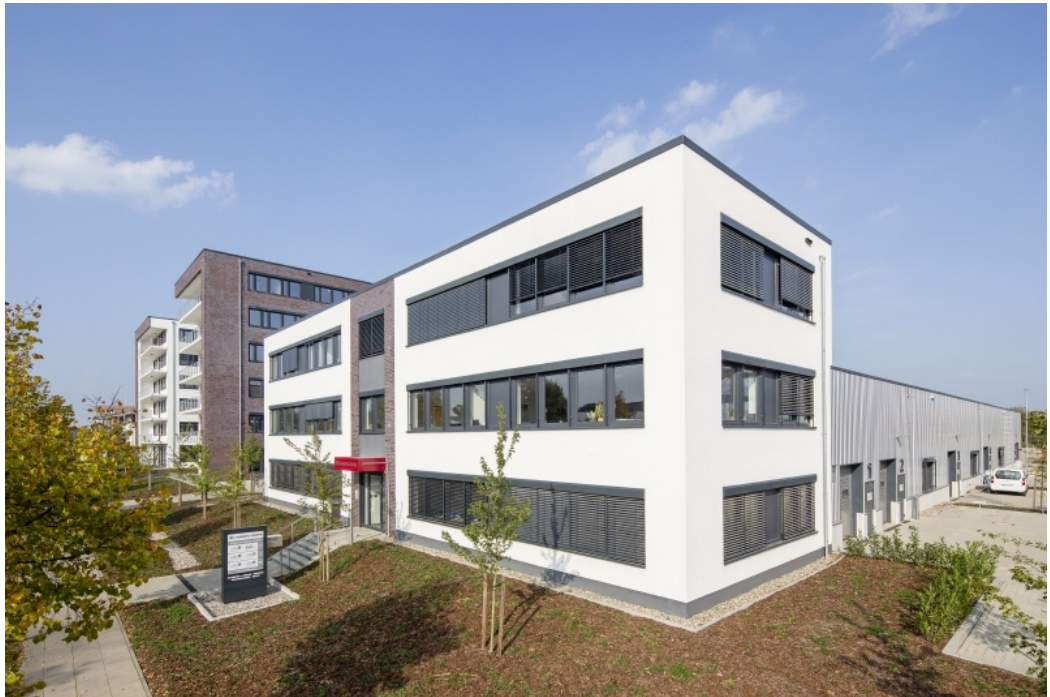
EUROPA-CENTER Finkenwerder Logistikhalle und Bürovorbau
