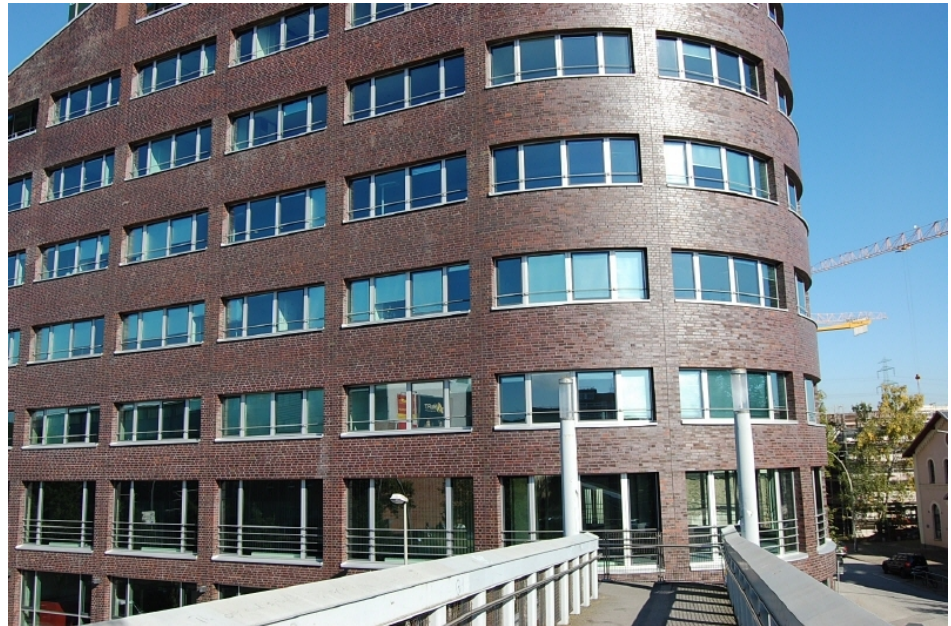
Ansicht von der Brücke
