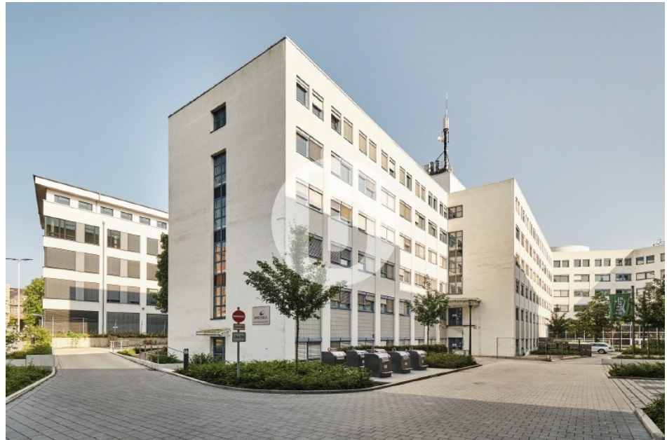
Marzipanfabrik Haus 19 Außenansicht
