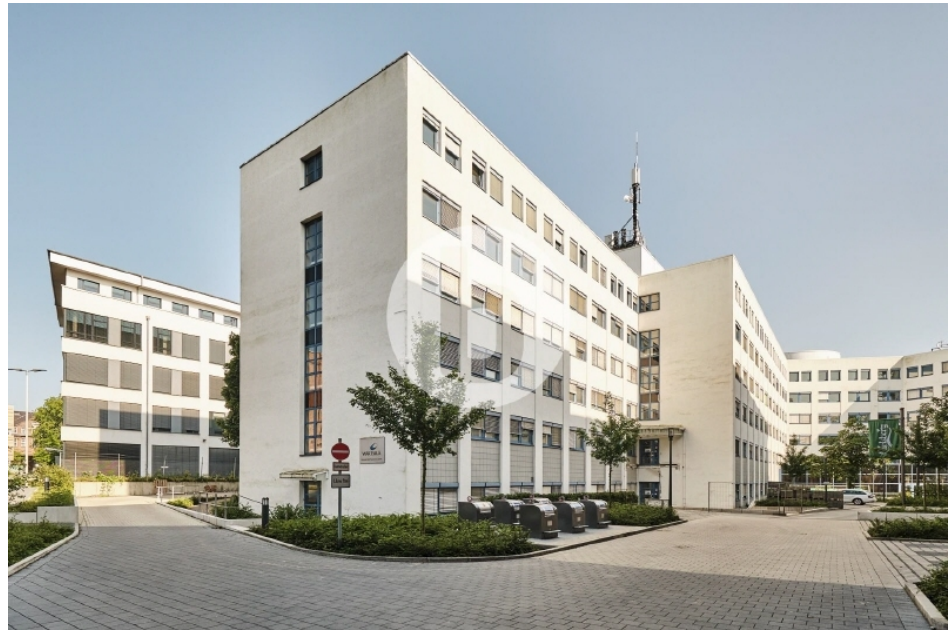
Marzipanfabrik Haus 19 Außenansicht
