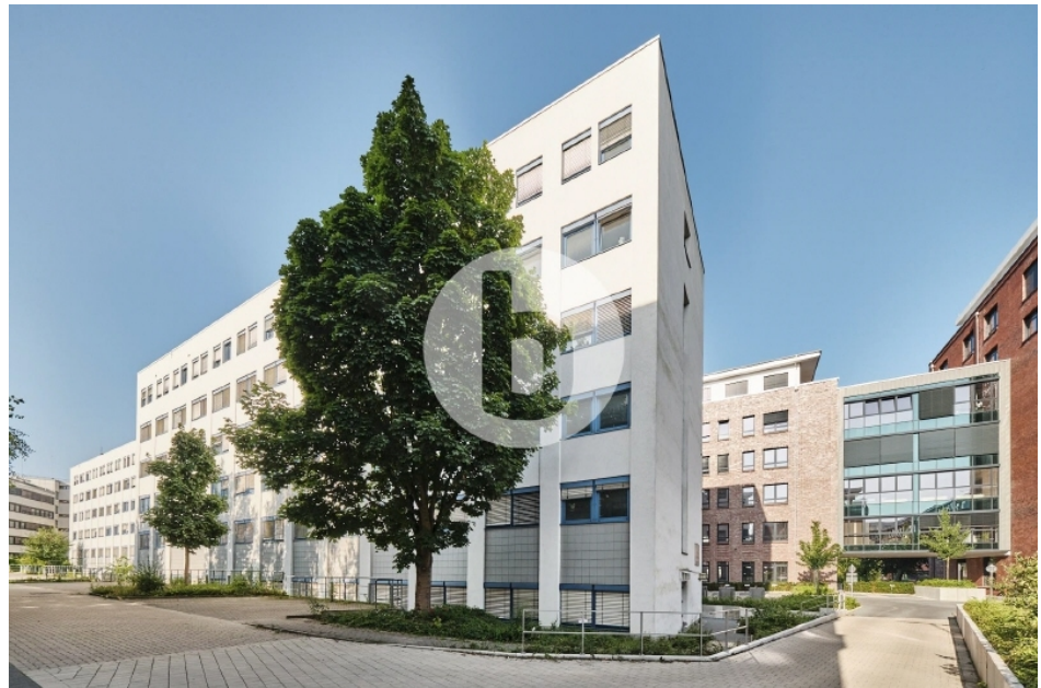
Marzipanfabrik Haus 19 Außenansicht
