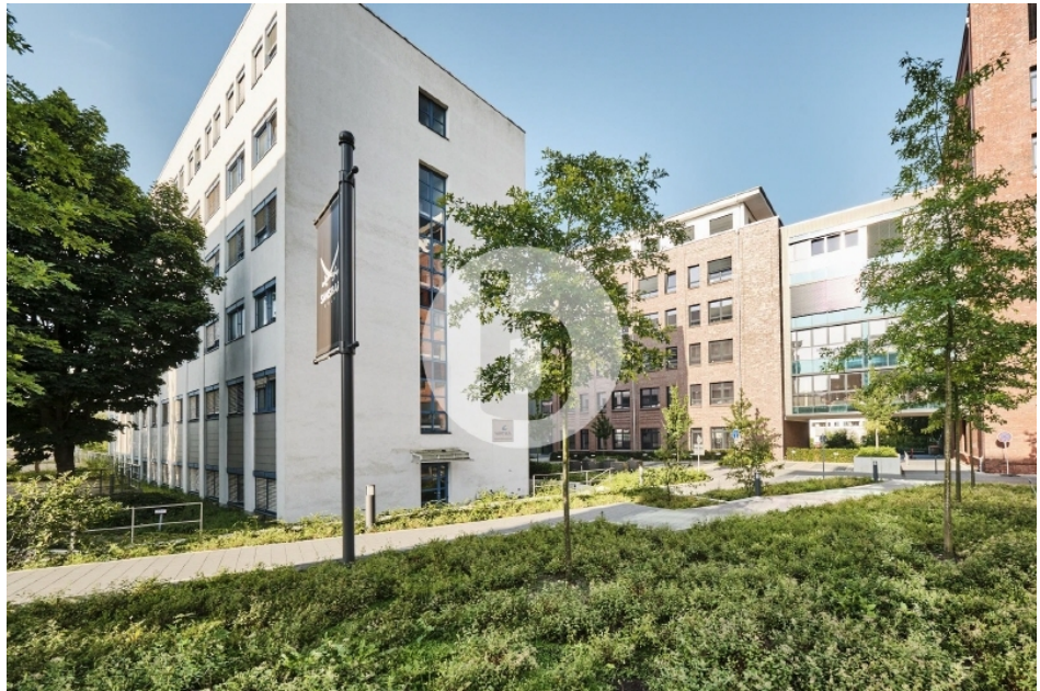
Marzipanfabrik Haus 19 Außenansicht
