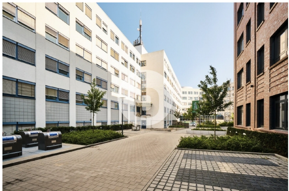
Marzipanfabrik Haus 19 Außenansicht
