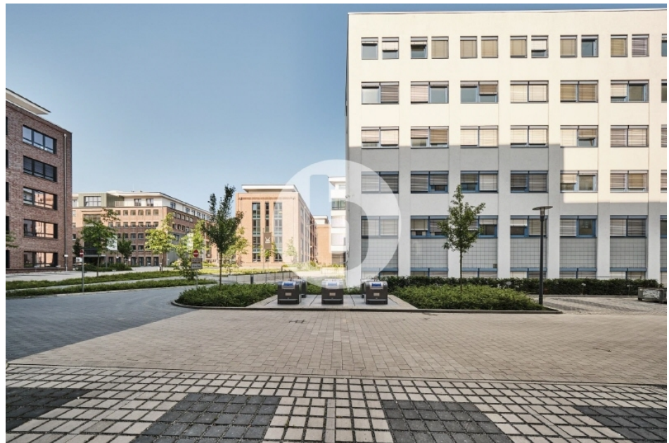
Marzipanfabrik Haus 19 Außenansicht
