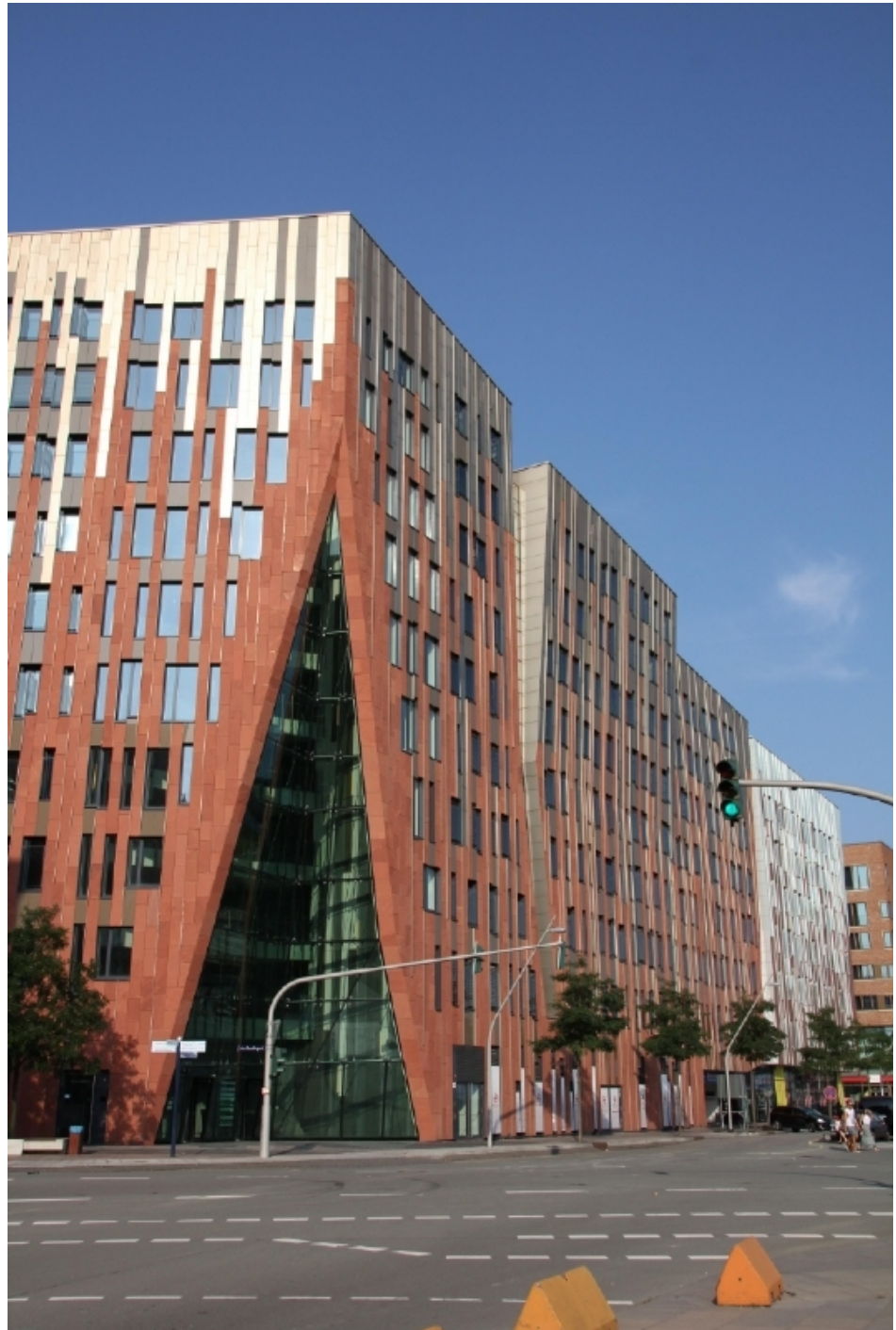
Ansicht II Gebäudekomplex
