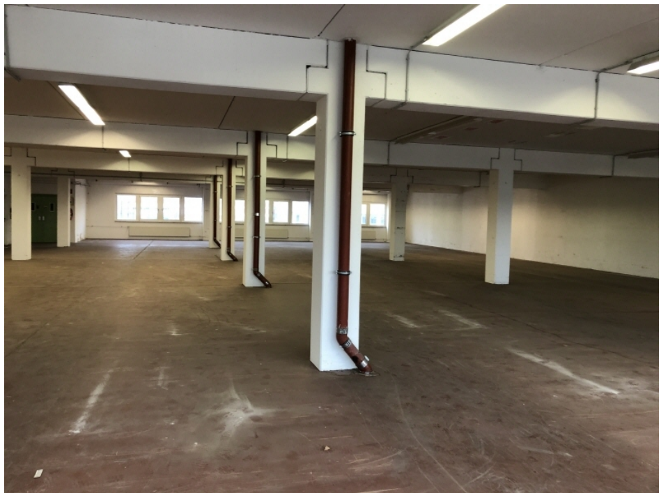
Halle mit Lastenfahrstuhl
