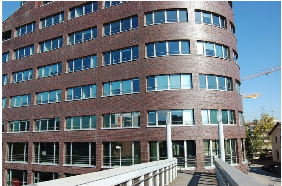
Ansicht von der Brücke
