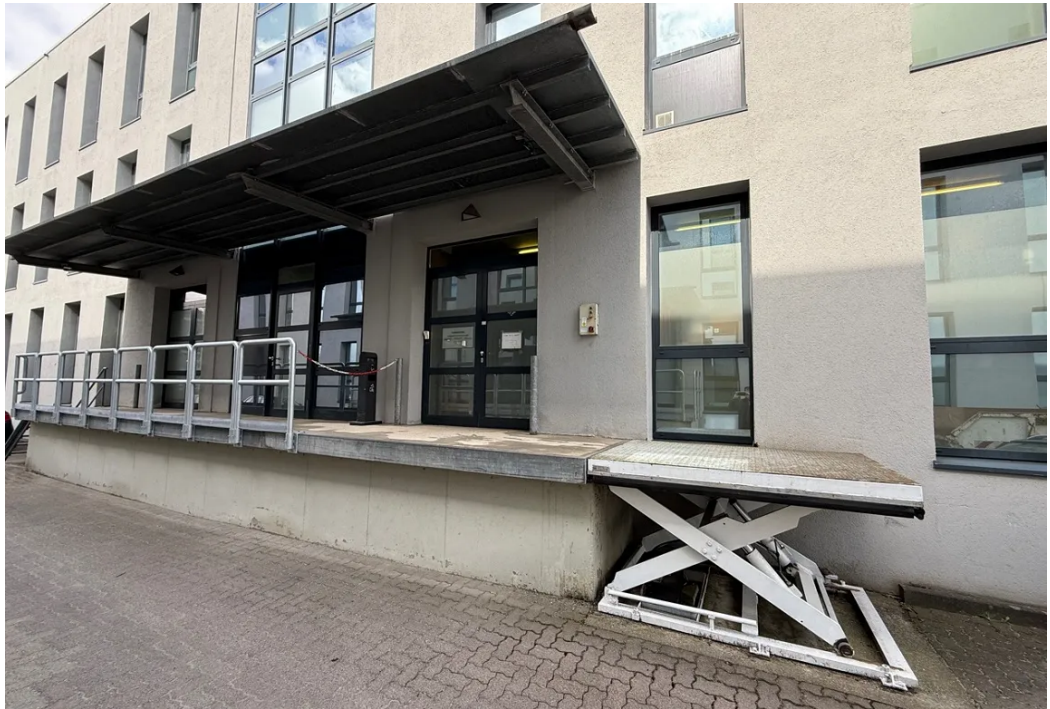
Rampe mit Hubtisch
