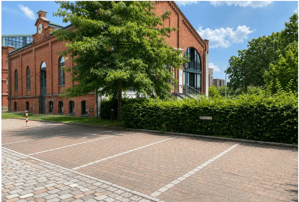
Außenansicht mit Stellplätzen
