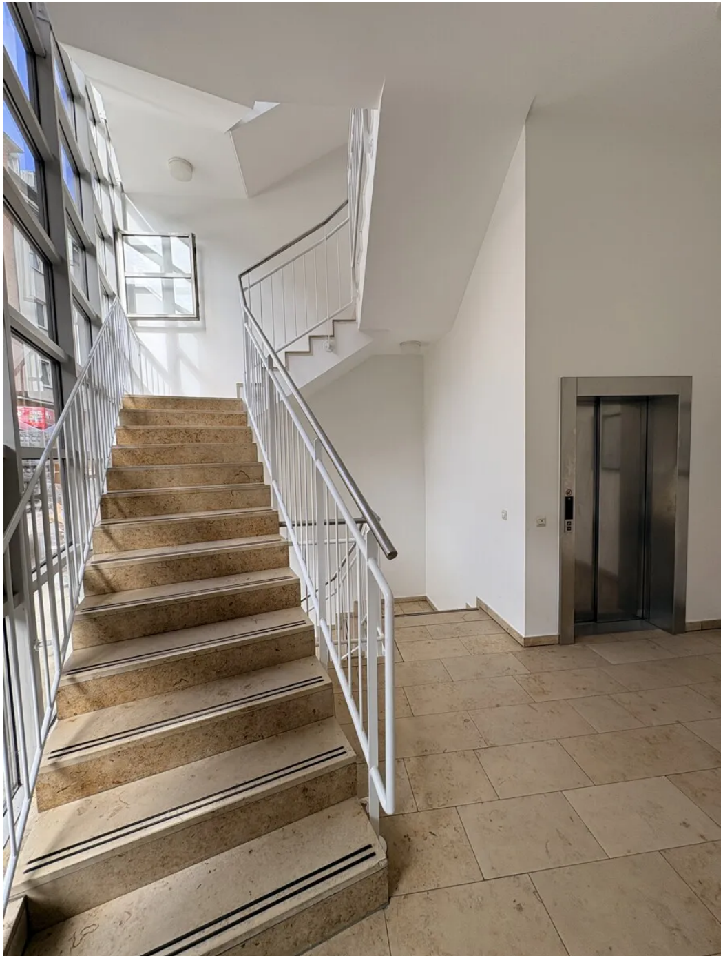
Treppenhaus mit Fahrstuhl
