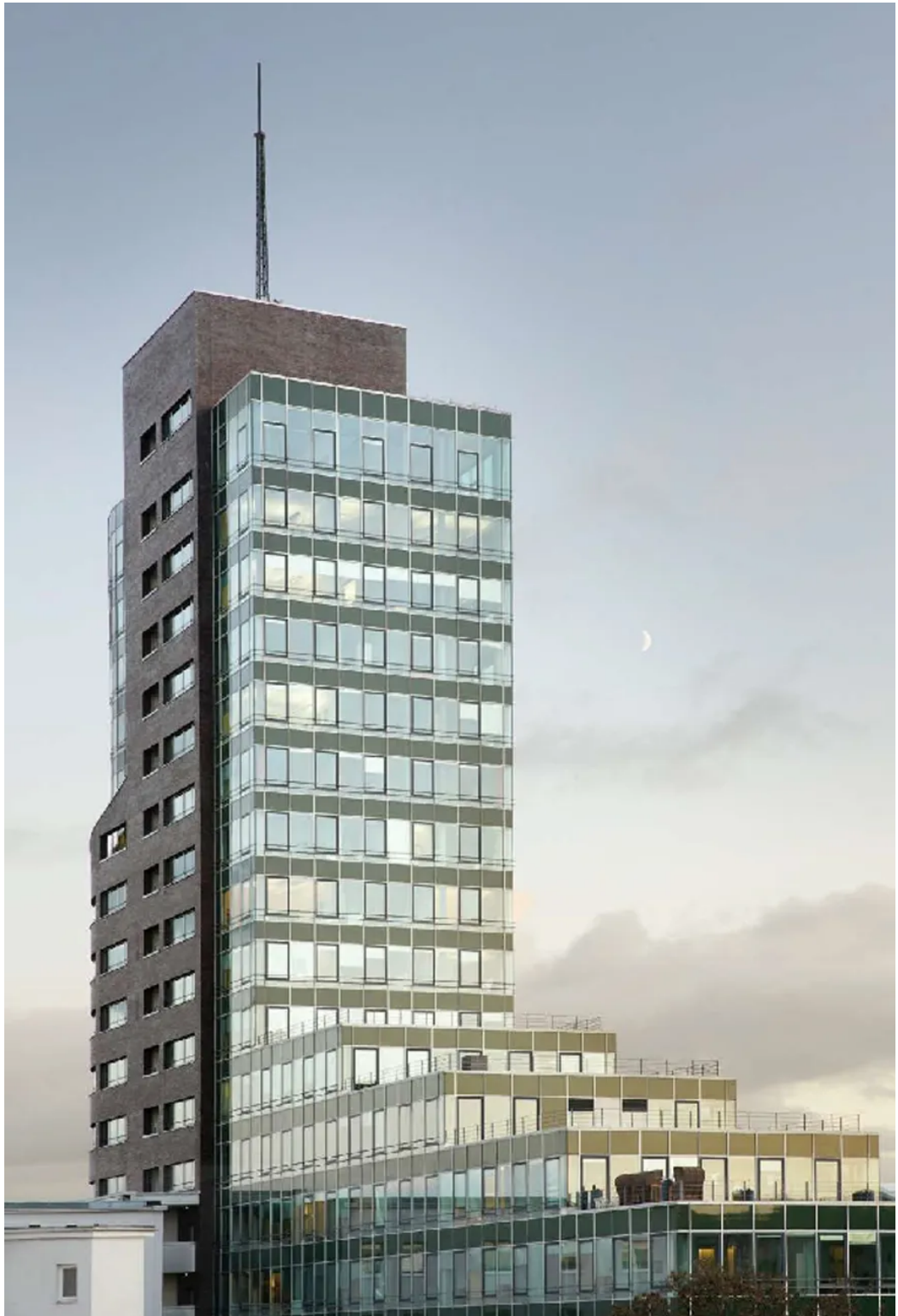
Weitere Ansichten - Channel Tower
