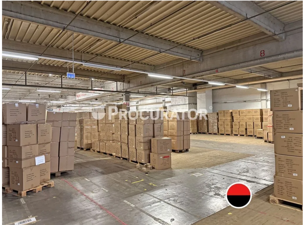
Hallen- und Büroansicht
