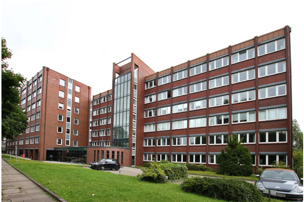
Gebäudeansicht mit Haus "a" im Vordergrund
