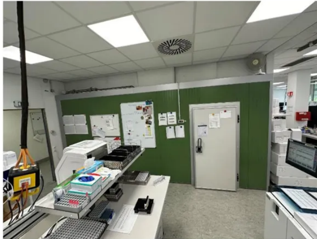
Labor- Groß EG Zentrallabor Kühlhaus groß (4J NP 11.000 €)
