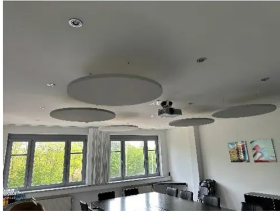
GF Etage Konferenzraum Groß Akustikelemente Decke
