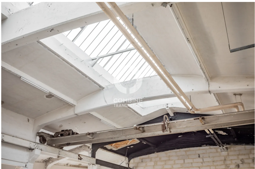
Ansicht Halle links
