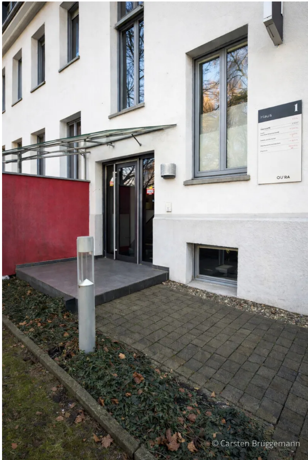
Zugang zum Gebäude
