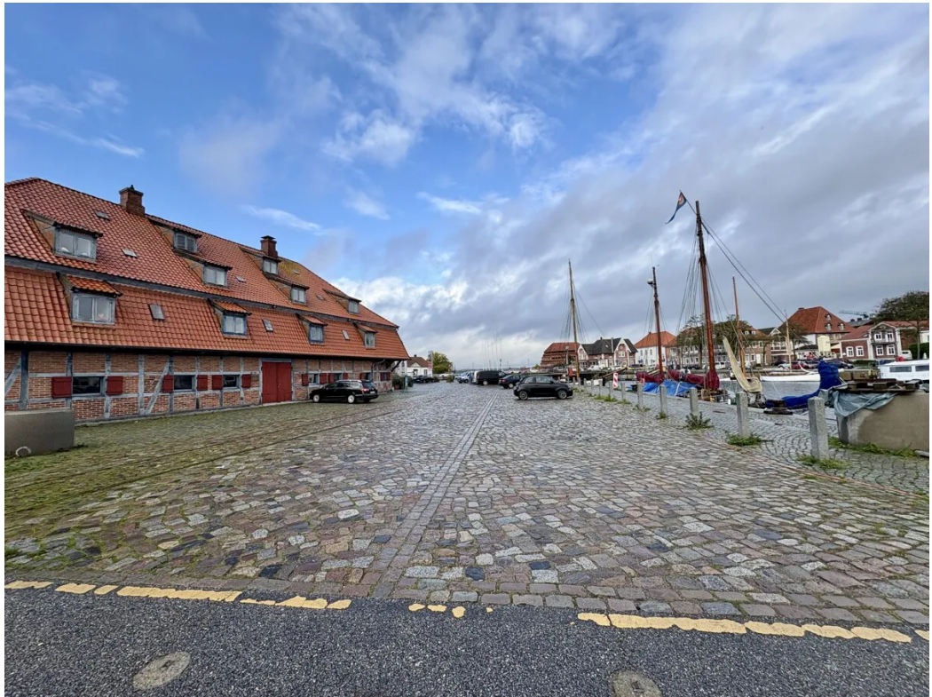
Zufahrt zum Hospital Quartier
