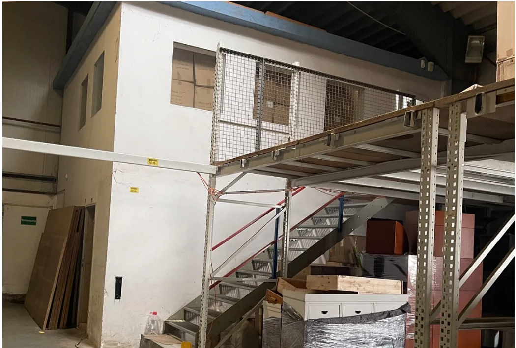
Büro und Sanitärbereich
