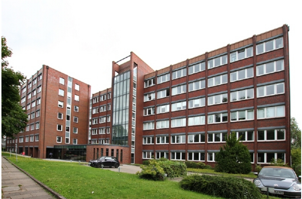
Gebäudeansicht mit Haus a im Vordergrund
