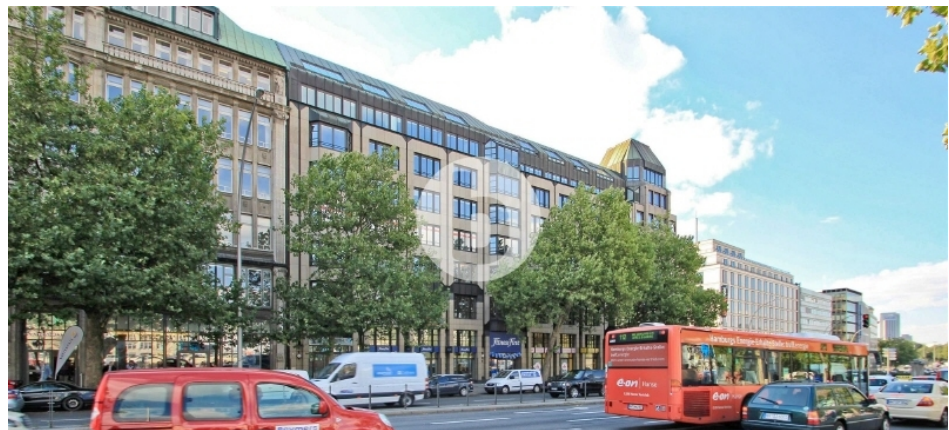
Glockengießerwall City Hamburg Bürogebäude Hamburg Außenan
