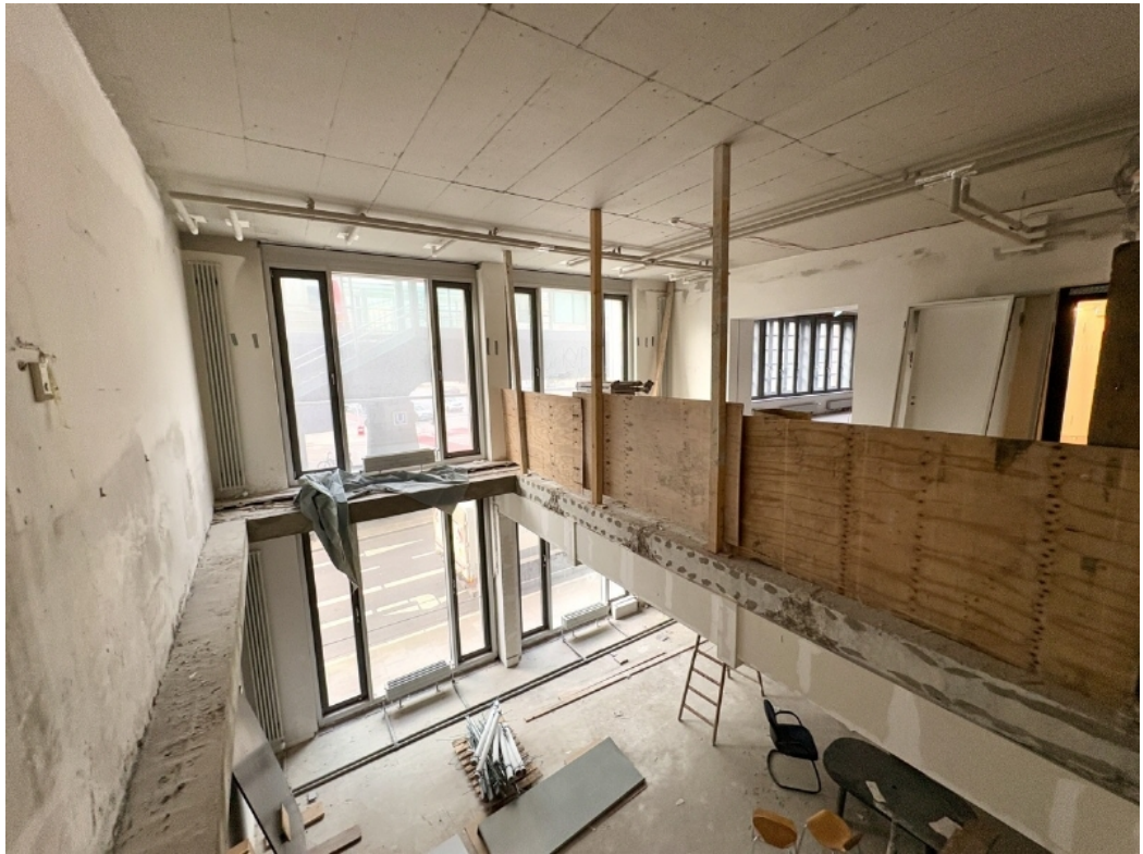
Blick von der Galerie in das EG
