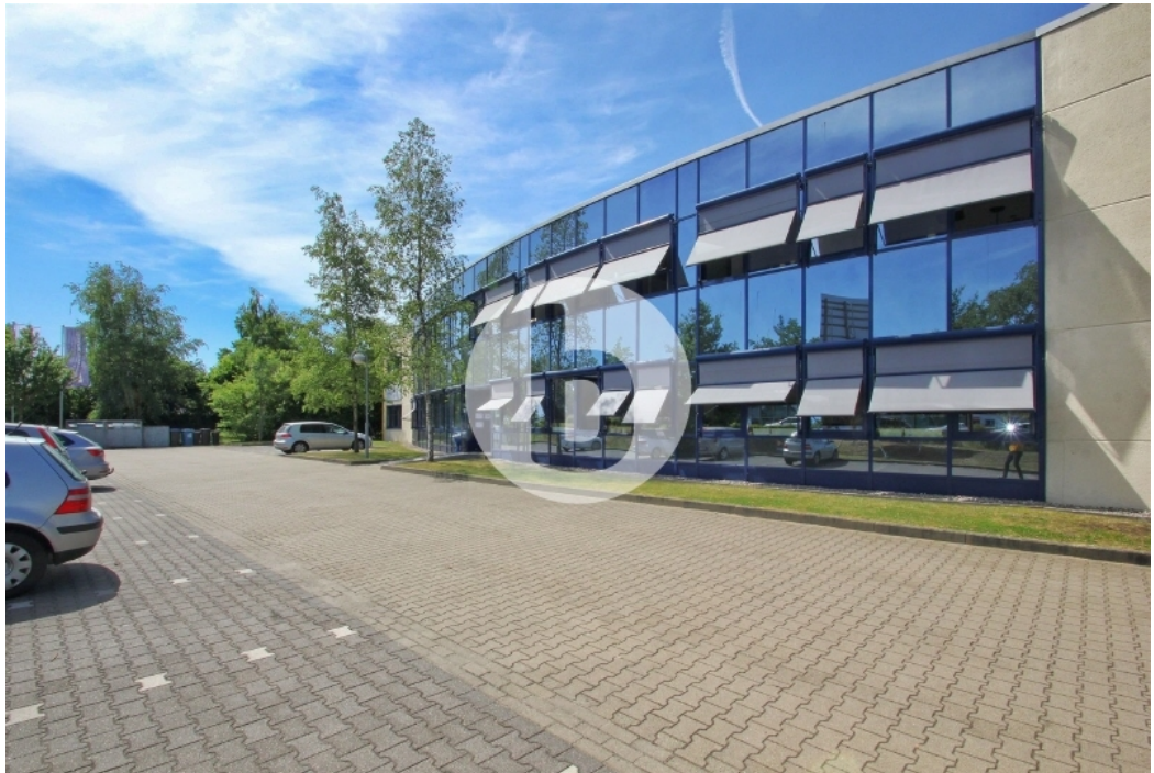
Business Quartier Glinde Büro Lager Außenansicht
