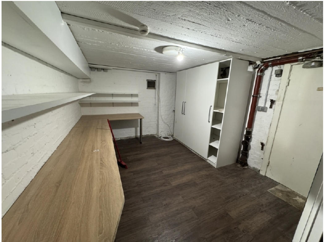
Lagerraum im Keller
