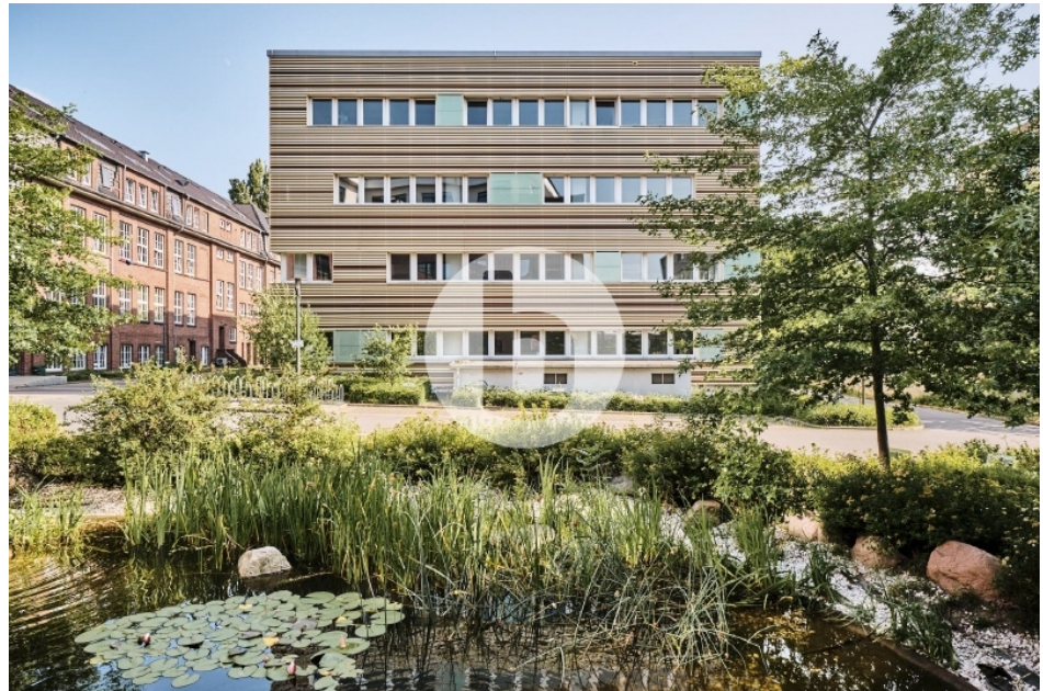
Marzipanfabrik Haus 23 Außenansicht
