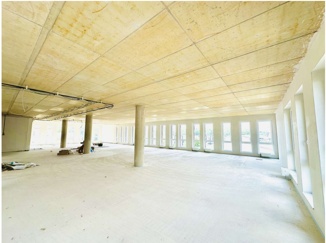
Fläche im Rohbau
