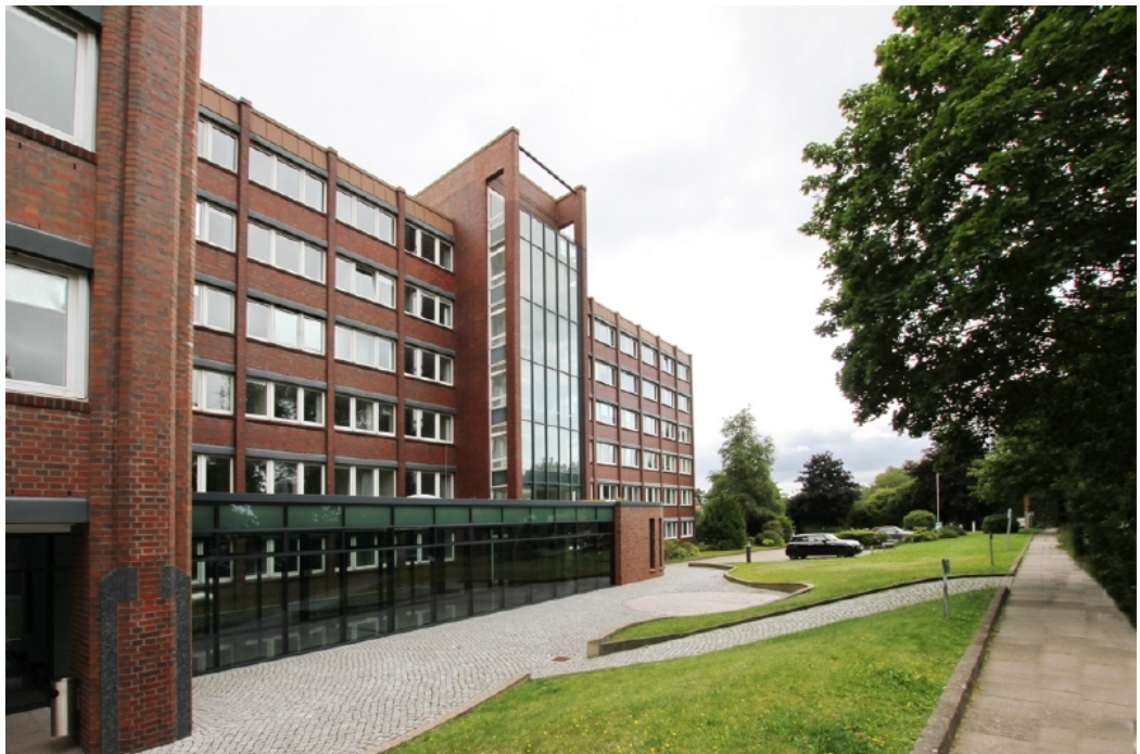
verglaster Übergang mit Hs a im Hintergrund
