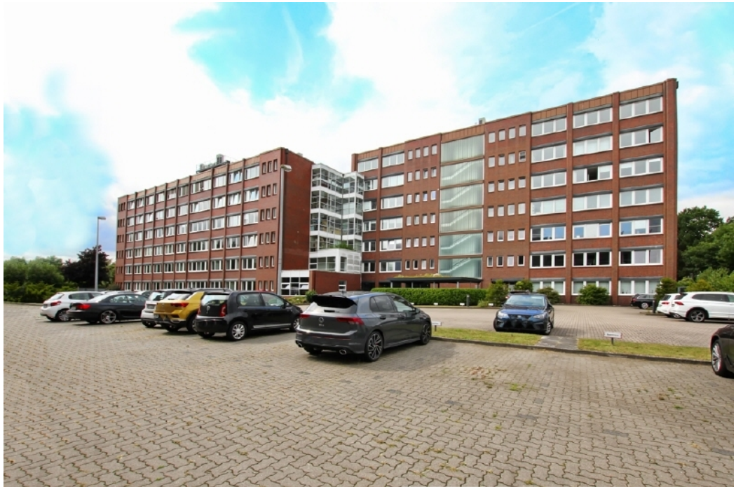
Gebäudeansicht Haus a und b
