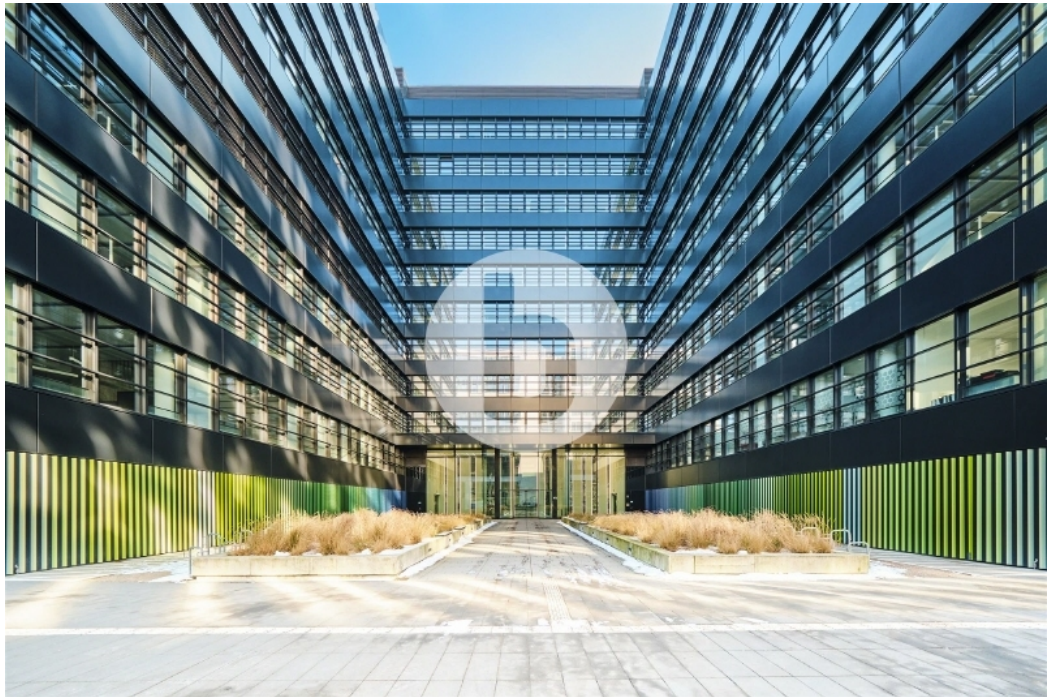
Fleetoffice Heidenkampsweg 74-76 20097 Hamburg City Süd Bürogebäude Außenansicht
