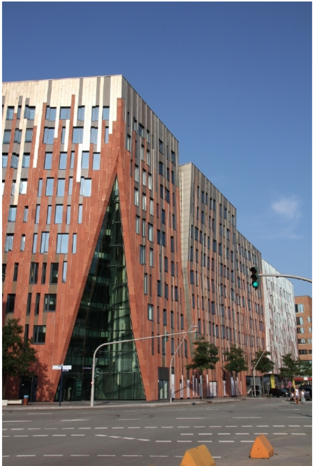
Ansicht II Gebäudekomplex
