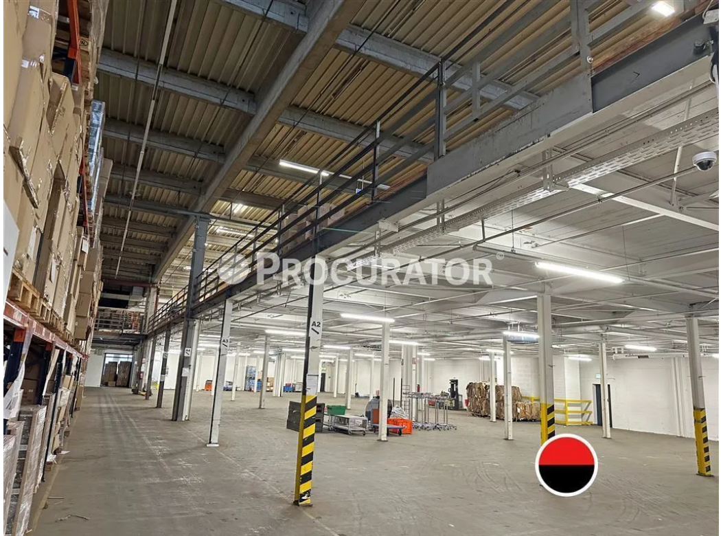
Hallen- und Büroansicht
