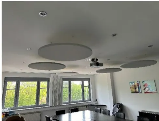
GF Etage Konferenzraum Groß Akustikelemente Decke
