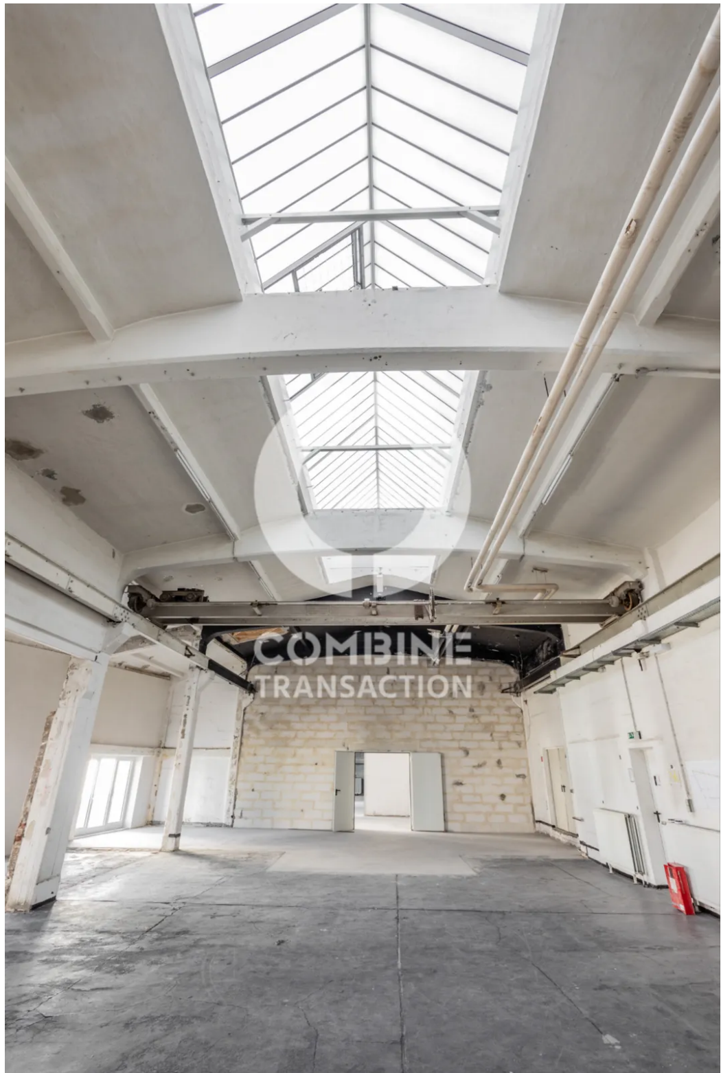
Ansicht Halle links
