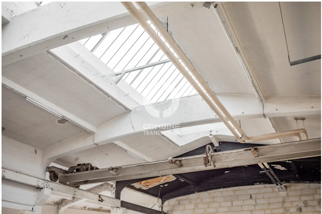
Ansicht Halle links
