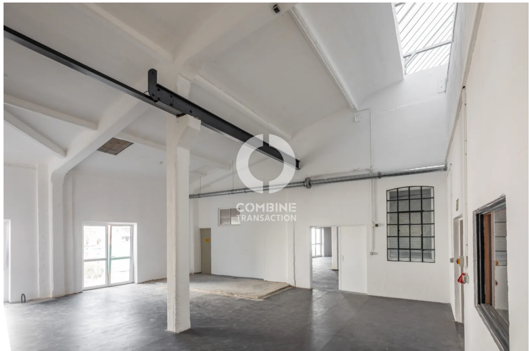
Ansicht Teilbereich Halle links
