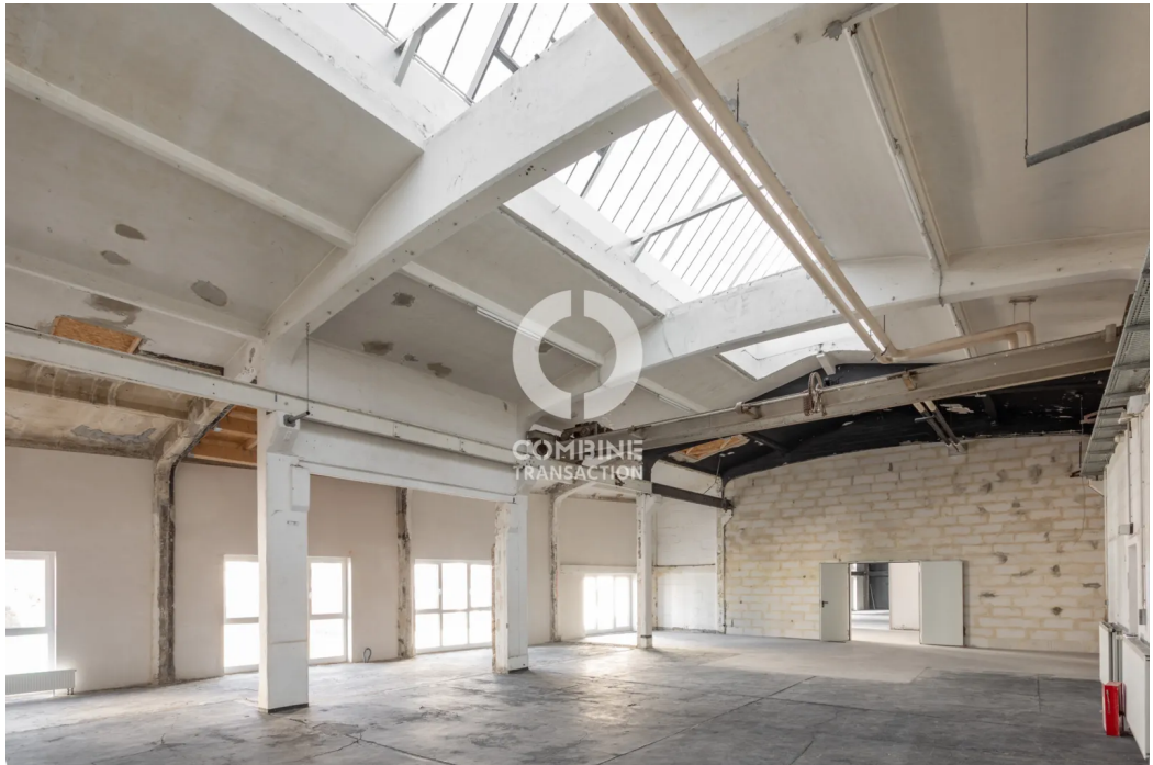
Ansicht Halle links
