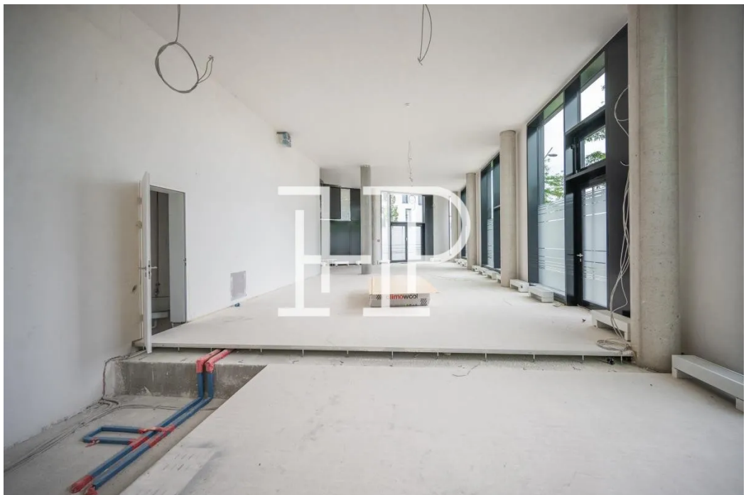
Deckenhöhen bis zu 3,5 m
