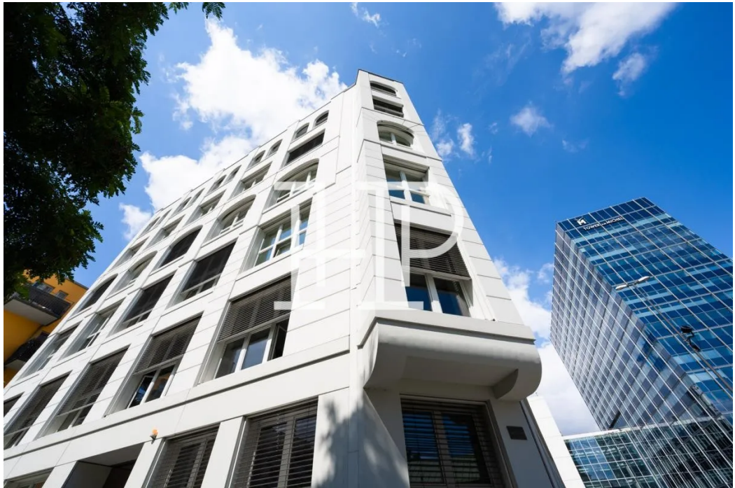
Fassade im Detail
