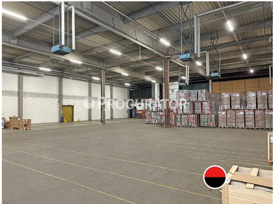
Hallen- und Büroansicht
