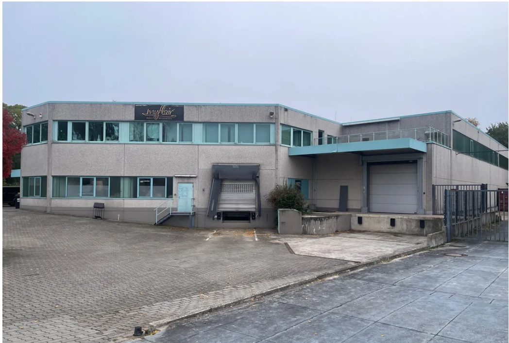
Außenansicht rechte Seite des Gebäudes mit 2 Rampen
