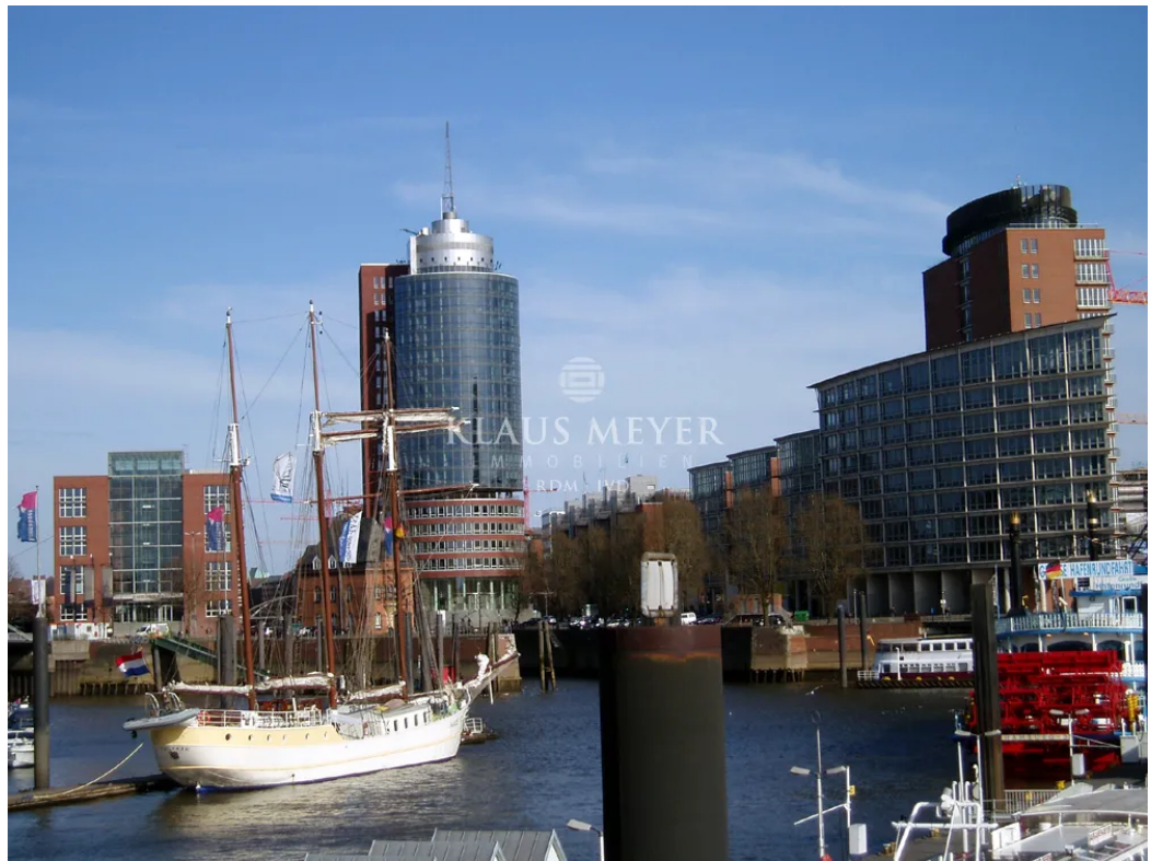
Gebäudekomplex Columbus am Undsen Elbansicht kmi weiss 49
