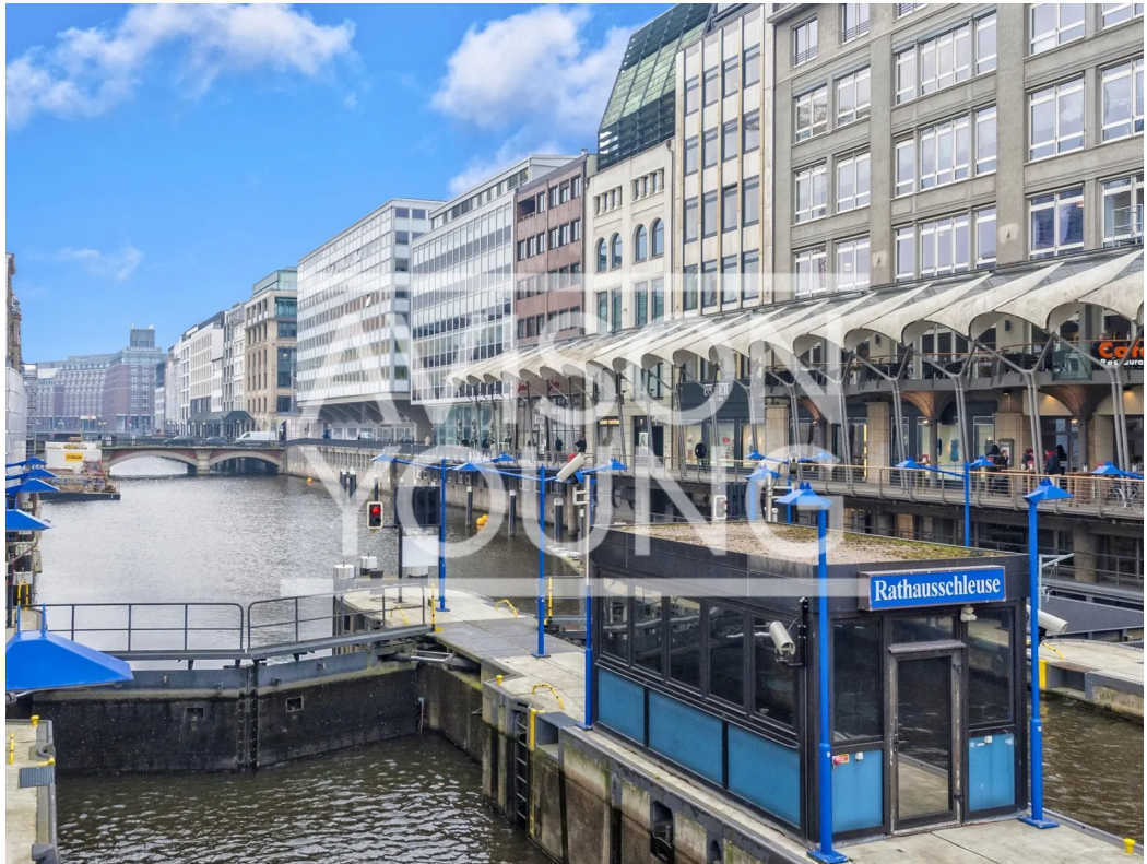
Blick über den Kanal
