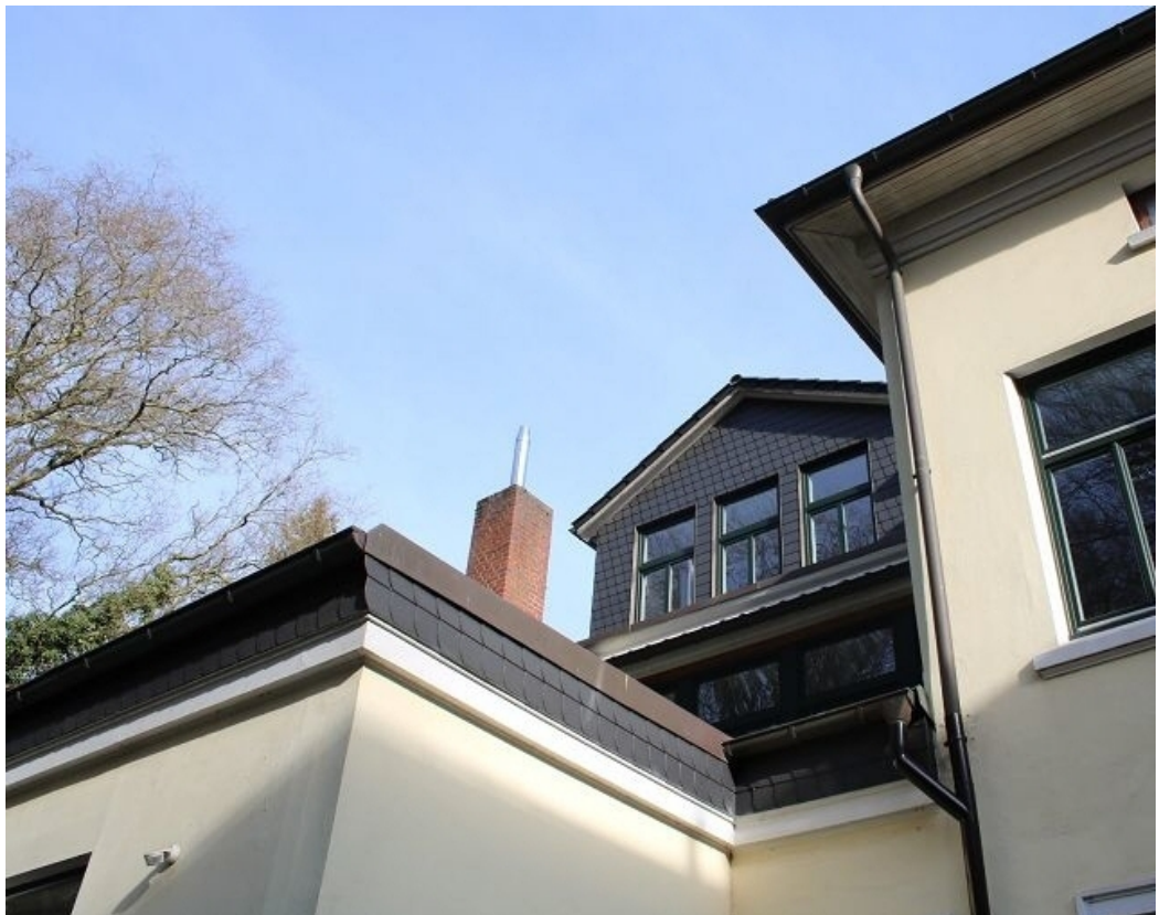
Blick aufs Dachgeschoß von außen
