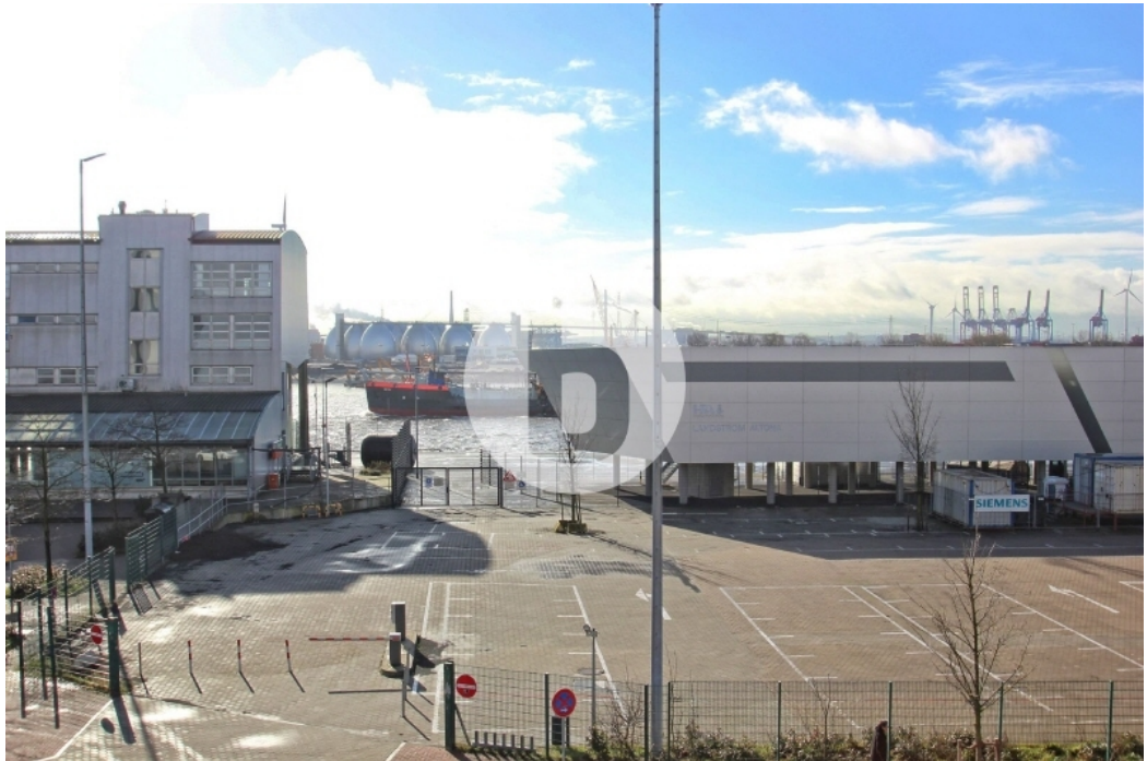
Große Elbstraße Hamburg Altona Bürogebäude Ausblick
