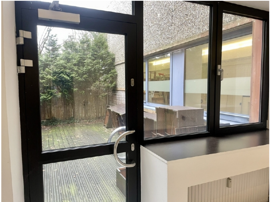
Zugang zur Terrasse
