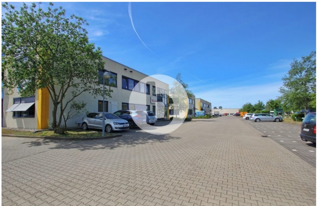
Business Quartier Glinde Büro Lager Außenansicht
