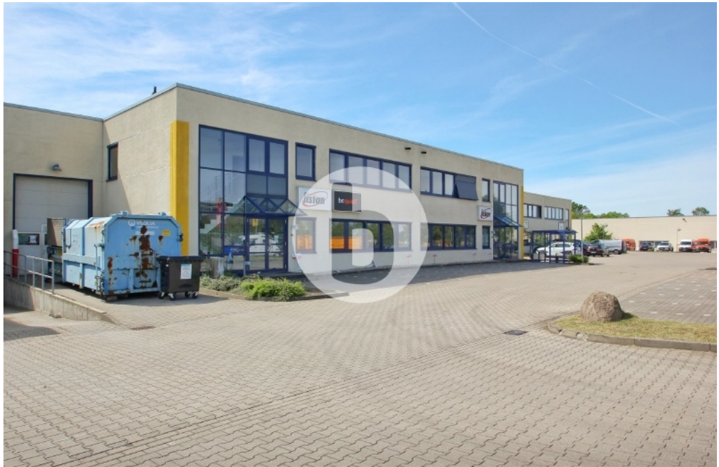
Business Quartier Glinde Büro Lager Außenansicht
