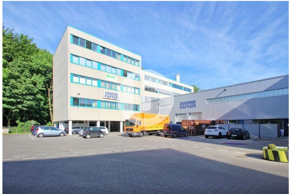
Schnackenburgallee 149 22525 Hamburg Büro Halle Außenansicht
