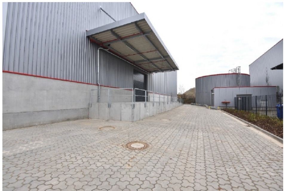
Ansicht der Rampe
