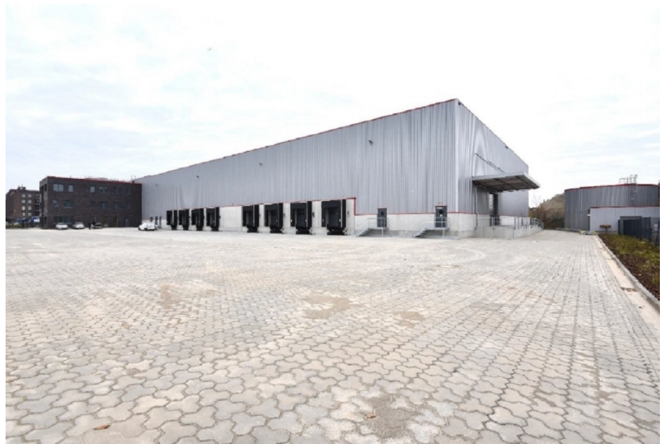
Seitenansicht Lagerhalle und Bürogebäude
