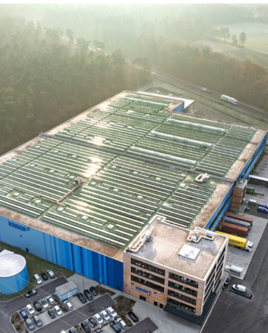
Gründach trifft Energiekonzept: Kühlung und Dämmung durch Begrünung – kombiniert die Immobilie der Kroop & Co. Transport + Logistik GmbH mit Photovoltaik und Geothermie.
